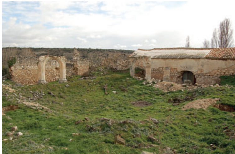
Vista de las pandas del refectorio y de la cilla
